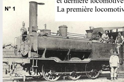
La première locomotive à vapeur était une machine-tender n° C. I, à 3 essieux, à roues de 1 m, de type « Bourbonnais » 030, produite en 1870 à Belfort par la Société Alsacienne de Construction Mécanique (SACM). En 1911, Henschel & Sohn (à Kassel en Allemagne) fournit deux locomotives-tenders à vapeur 020+020T, système Mallet (de l'ingénieur suisse Anatole Mallet), de 41 tonnes avec roues de 1,10 m, marquées « Cirey n° 2 » et « Cirey n° 3 ».
